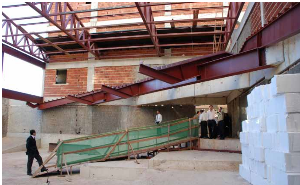
Diretoria do Sistema Cofeci-Creci esteve em Goiânia para conhecer a obra da futura sede no Jardim Goiás
